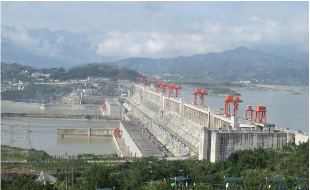
Figura 1-6. La mayor parte de la electricidad en el mundo la producen generadores sincrónicos. La figura muestra la planta hidroeléctrica de las tres gargantas sobre el río Yangtzé, en China. Esta central posee treinta generadores sincrónicos de 700 MW, cuyo peso es de unas 6.000 toneladas por unidad.
